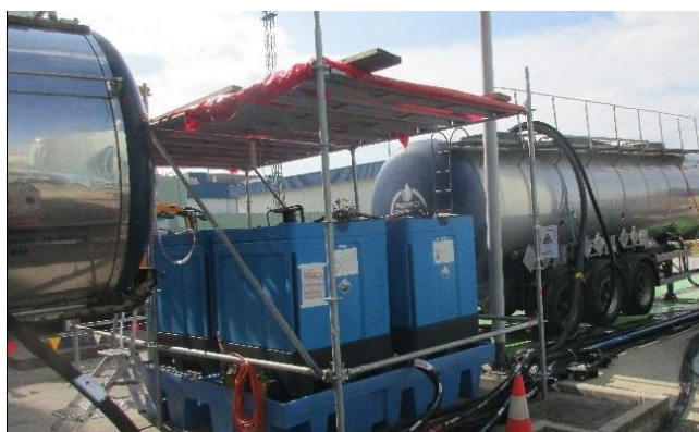
Slika 2 in 3: Remont 2019 – oprema za kemično čiščenje uparjalnikov
