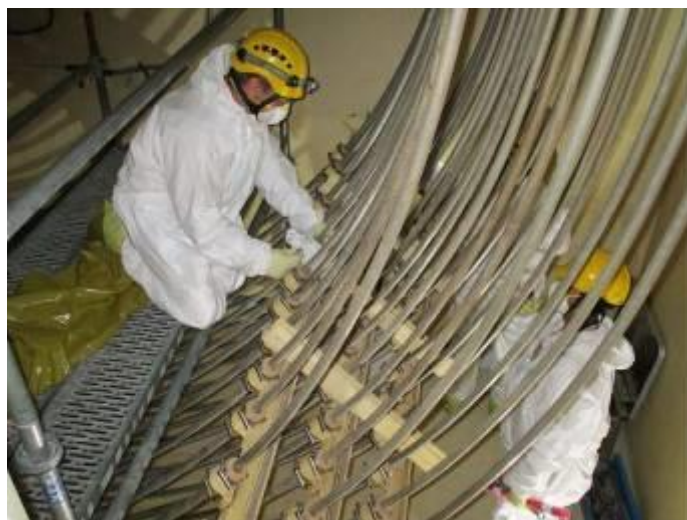
Slika 1: Remont 2019 – dela na vodilih sredične instrumentacije
