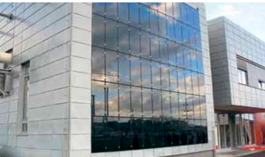
Integrirana sončna elektrarna na RTP Litostroj.
