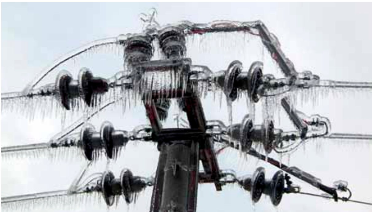
Žled na daljinovodnih stebrih na Brkinih.
