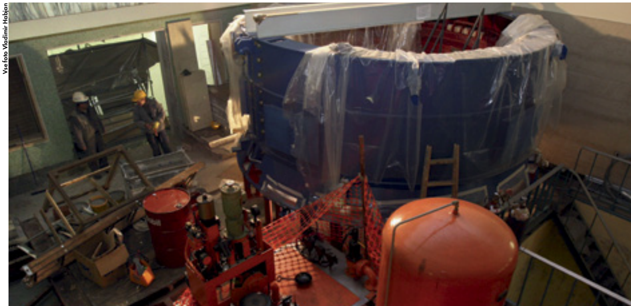
Stator v sklepni fazi sestavljanja.
