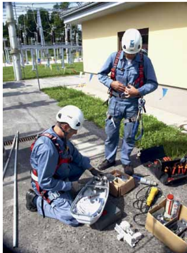
Zamenjava svetilk v RTP Kleče
