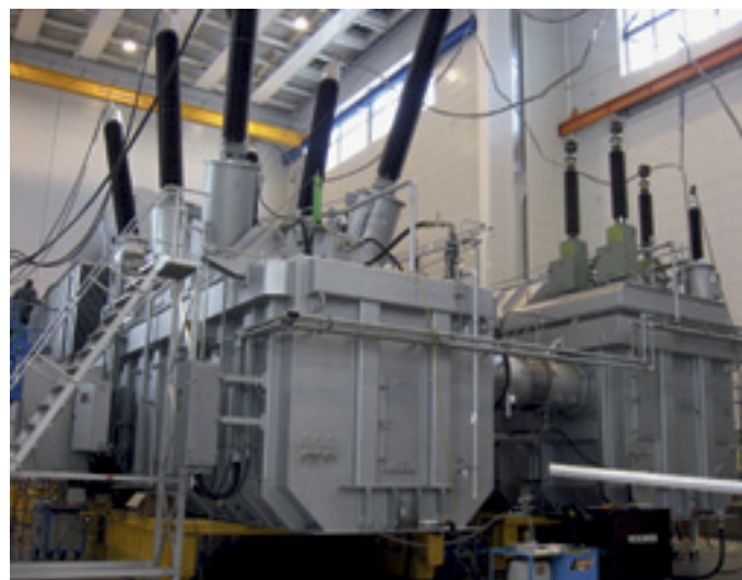
Prva enota prečnega transformatorja med preizkušanjem v tovarni Siemens v Weisu (Avstrija).
