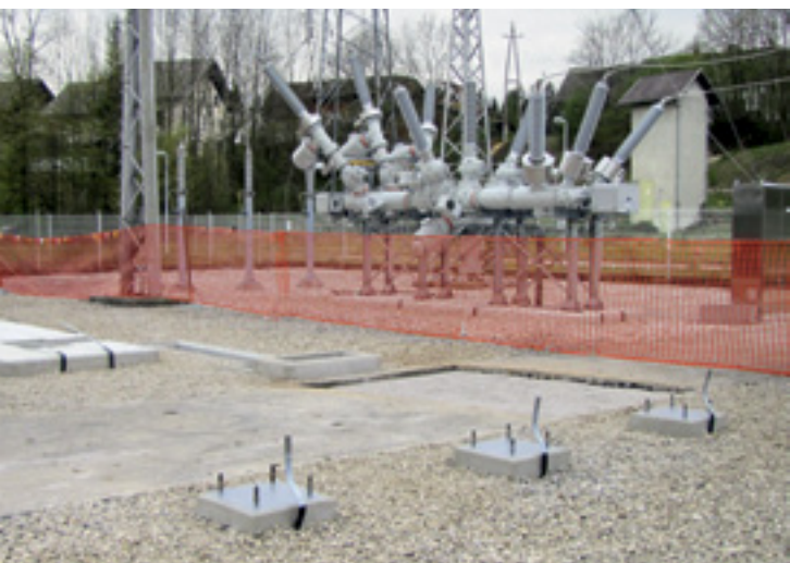
Temelji za novo zunanjo 110 kV hibridno enoto so pripravljeni.
