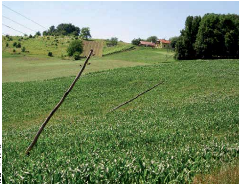
Foto arhiv Elektra Maribor
