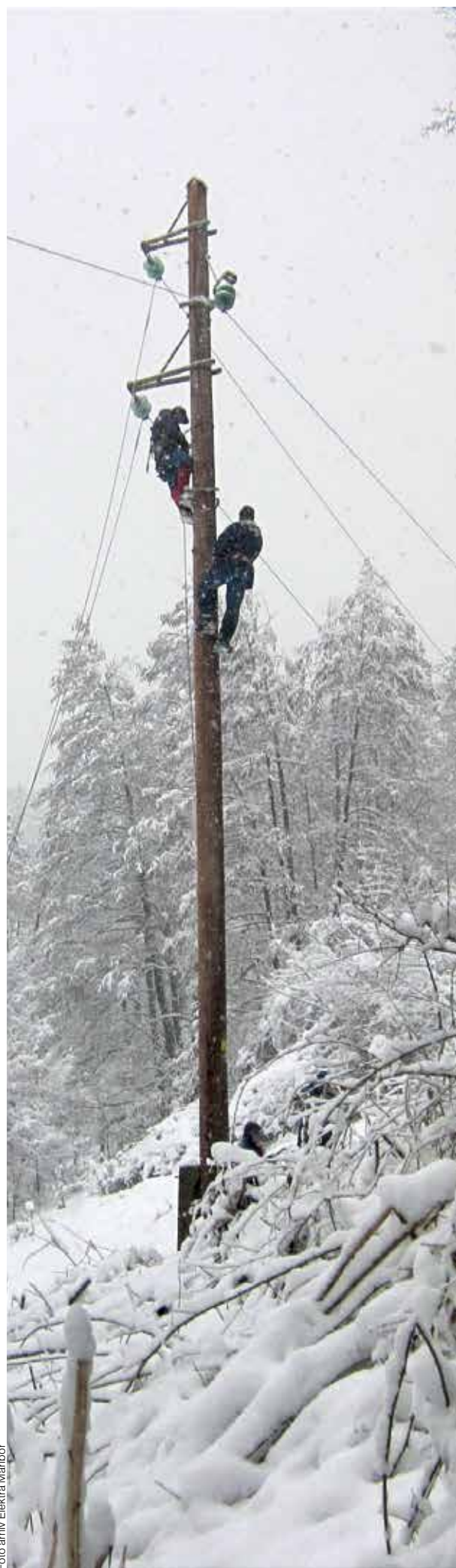
Foto arhiv Elektra Maribor
