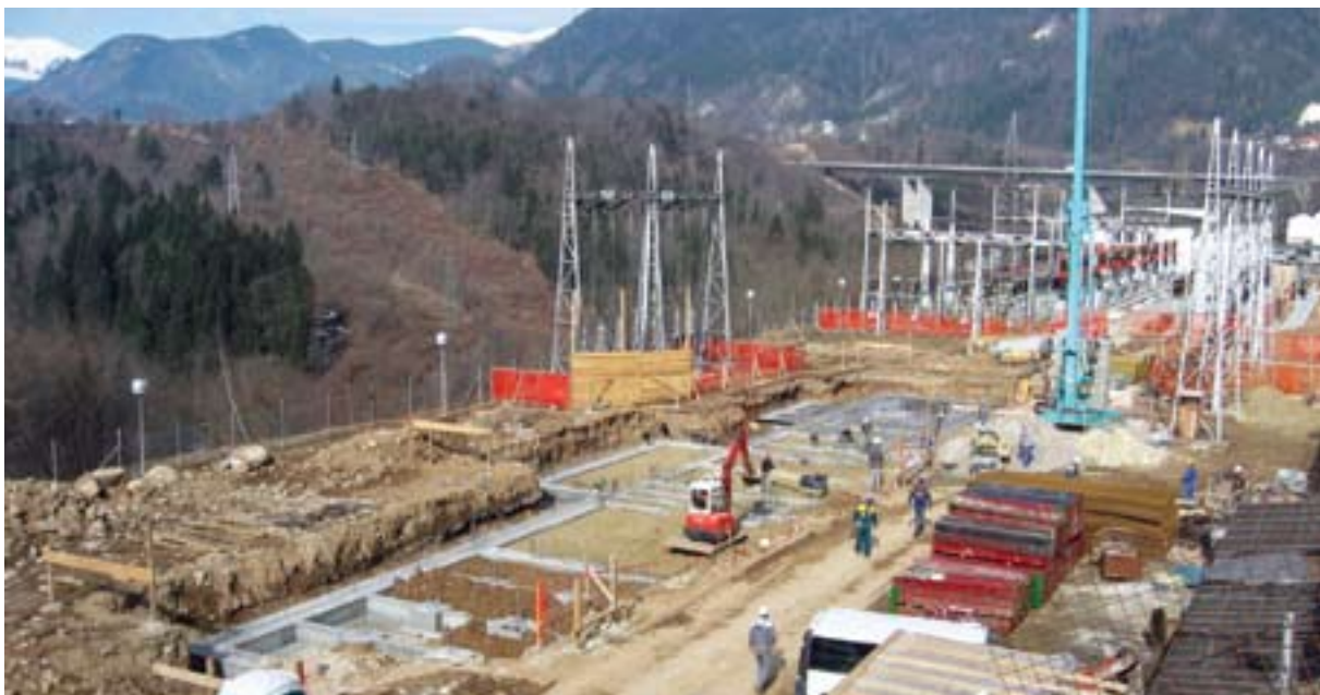
Temeljenje nove stavbe 110 in 20 kV stikališča, konec februarja 2009
