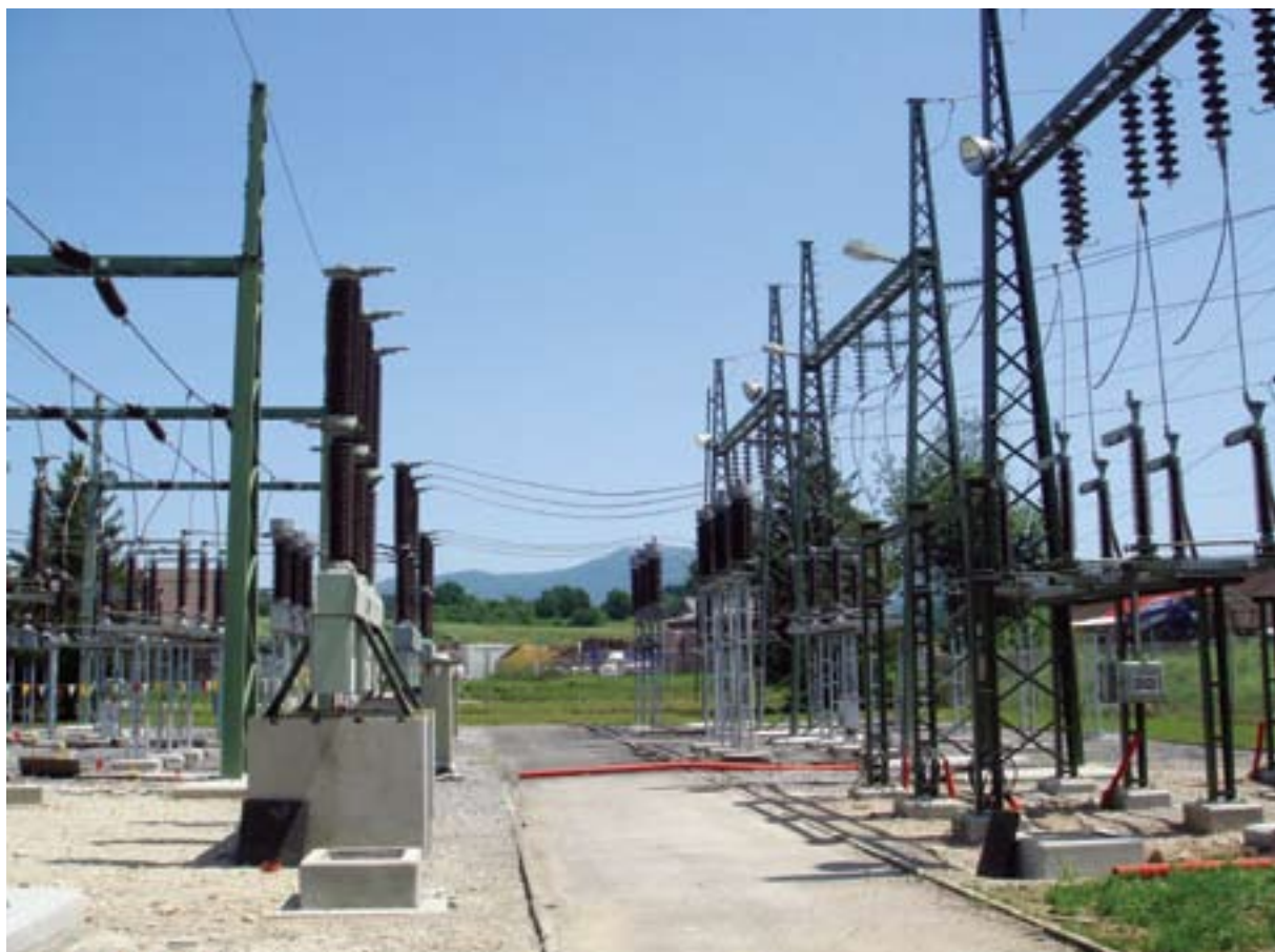
RTP Gotna vas – 110 kV stikališče med rekonstrukcijo.
