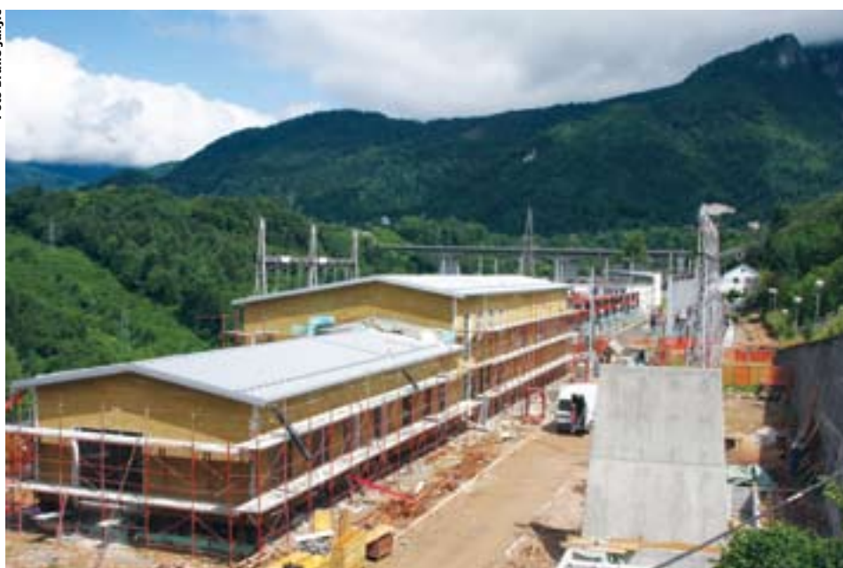
Pogled na novo stavbo GIS stikališča RTP Moste.
