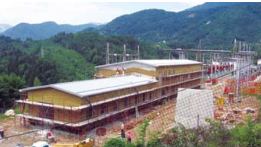
Sklepna dela na in v stavbi novega stikališča GIS, julija 2009.
