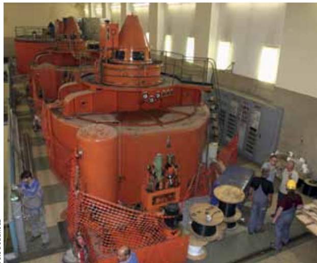
Prenovitelvena dela na agregatu 3 v HE Doblar gredo h koncu.
