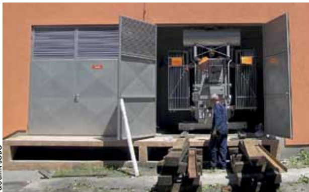
Vgradnja novega energetskega transformatorja v TP 2 20/10/0,4 kV transformatorsko postajo SODO TDR RUŠE.
