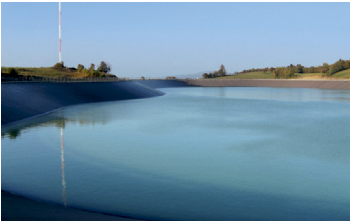
Zgornji akumulacijski bazen ČHE Avče z merilnim stolpom za veter.
