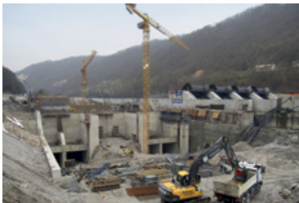
Pogled na očiščeno gradbeno jamo po poplavi.
