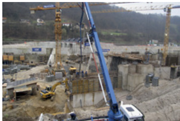
Betonaža krilnega zidu strojnice.
