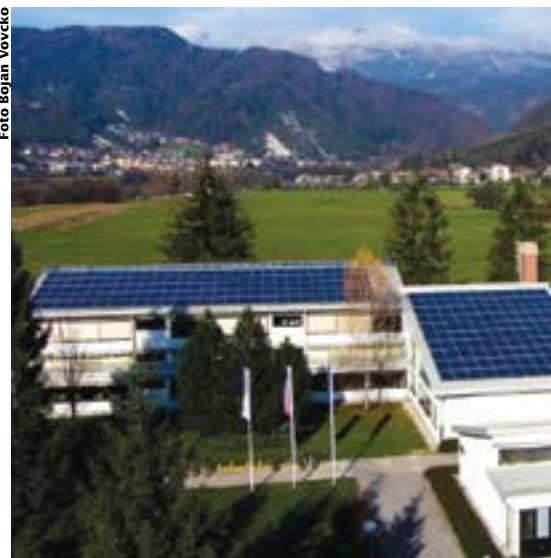
Namestitev fotovoltaične elektrarne na strehi poslovnih objektov TEB.
