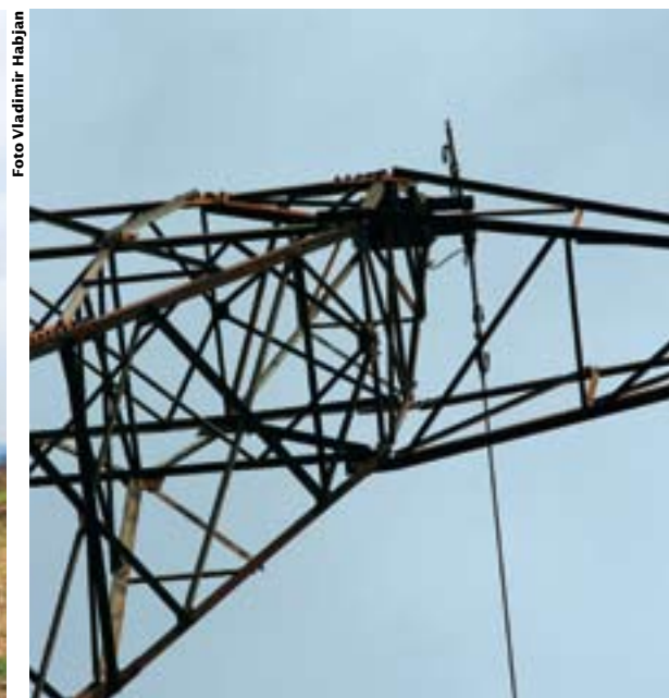
Odreznani vodnik na 400 kV daljnovodu Beričevo-Divača.
