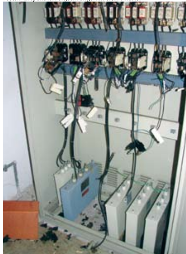
Povsem izropana notranjost transformatorske omarice.
