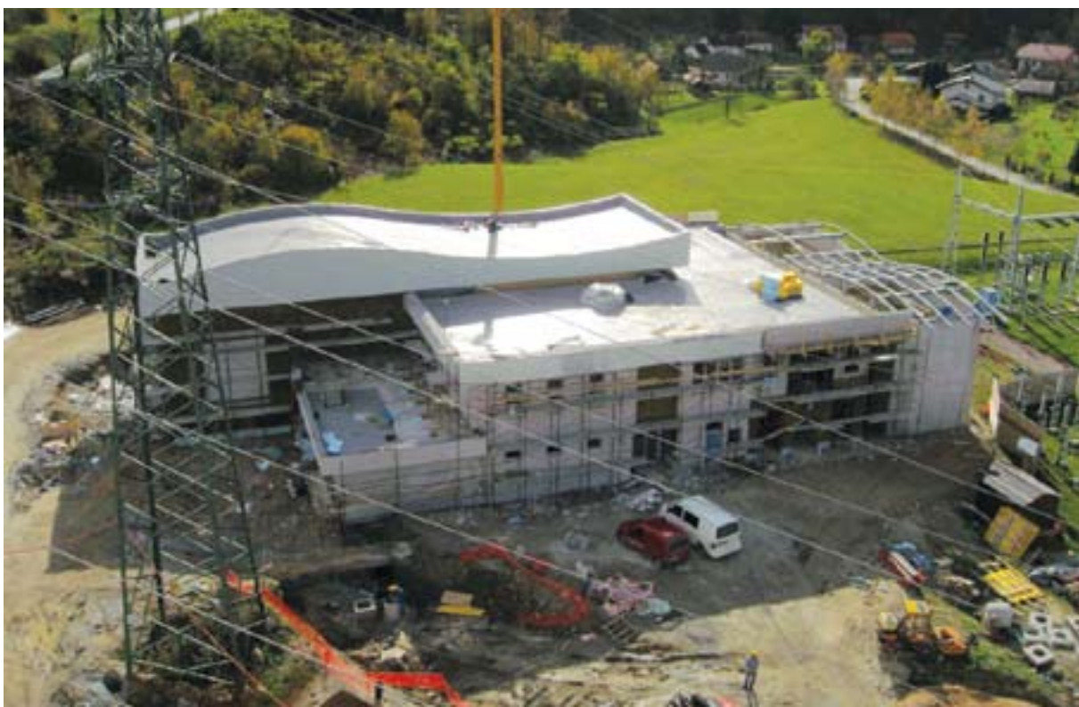
Pogled na novo stavbo stikališča.
