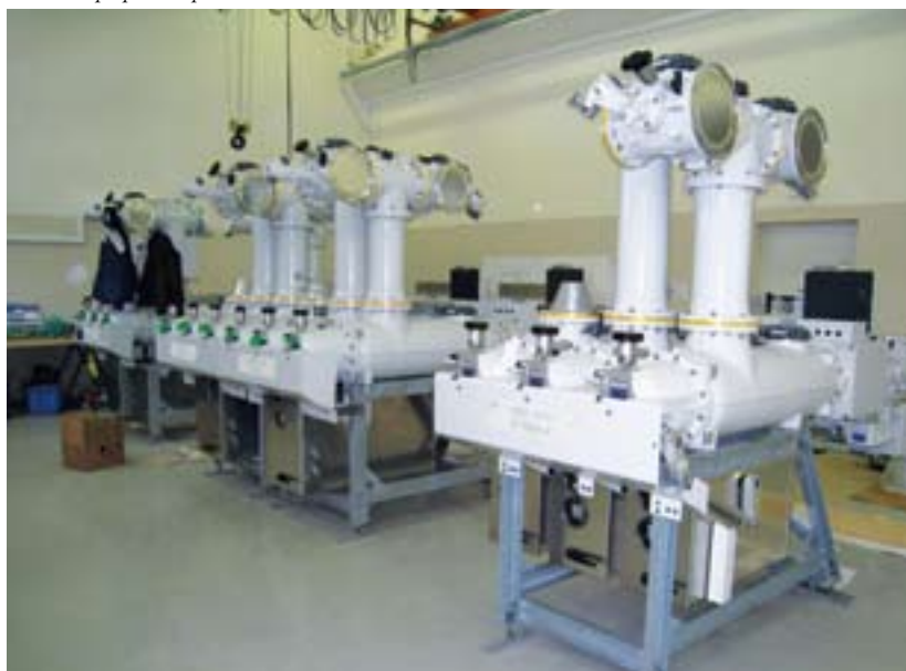
Prihod in priprava opreme GIS na montažo.
