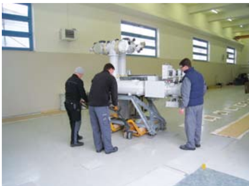
Prihod in priprava opreme GIS na montažo.
