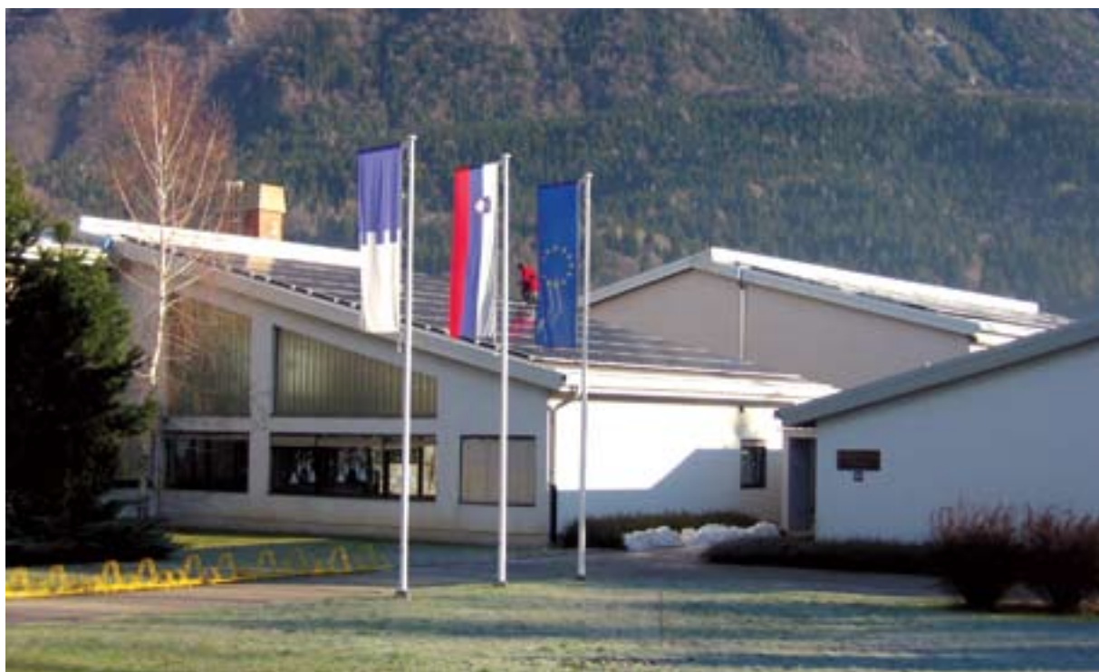
Sončna elektrarna Križe pod Kriško goro je od 23. decembra 2008 ponos investitorja, dobavitelja, izvajalcev, šole in občine.
