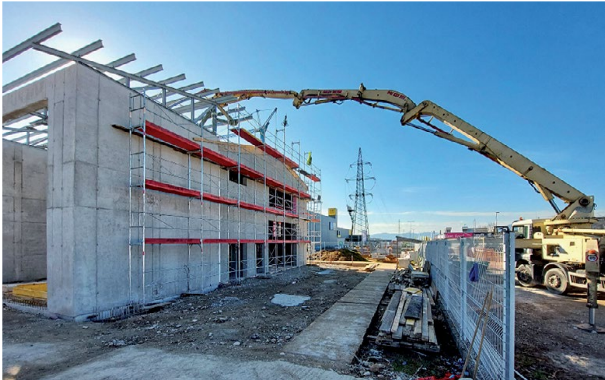
Potek gradnje RTP Primskovo.
