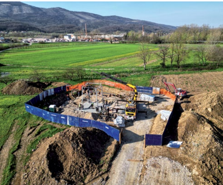
Utrinki z gradnje daljnovoda.
