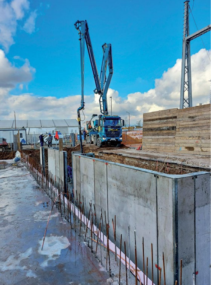
Potek gradnje RTP Primskovo.
