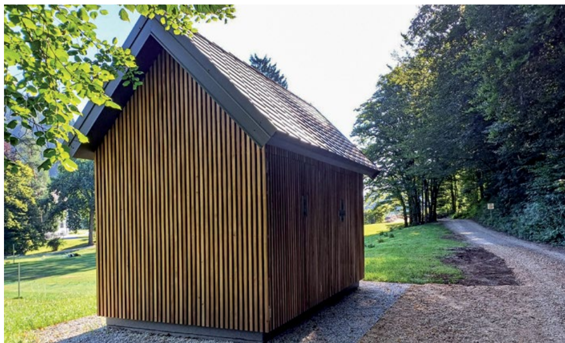
Nova transformatorska postaja Visoko.
