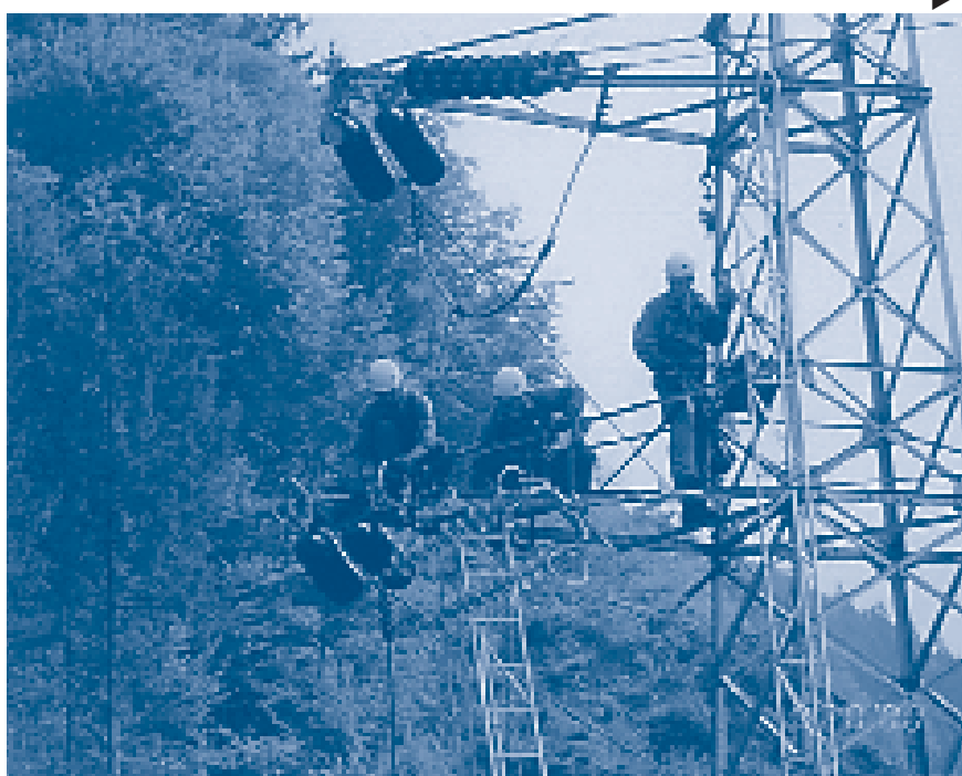
Daljnovod Vuhred-Ožbalt vzdrževalcem ne bo več povzročal težav.
