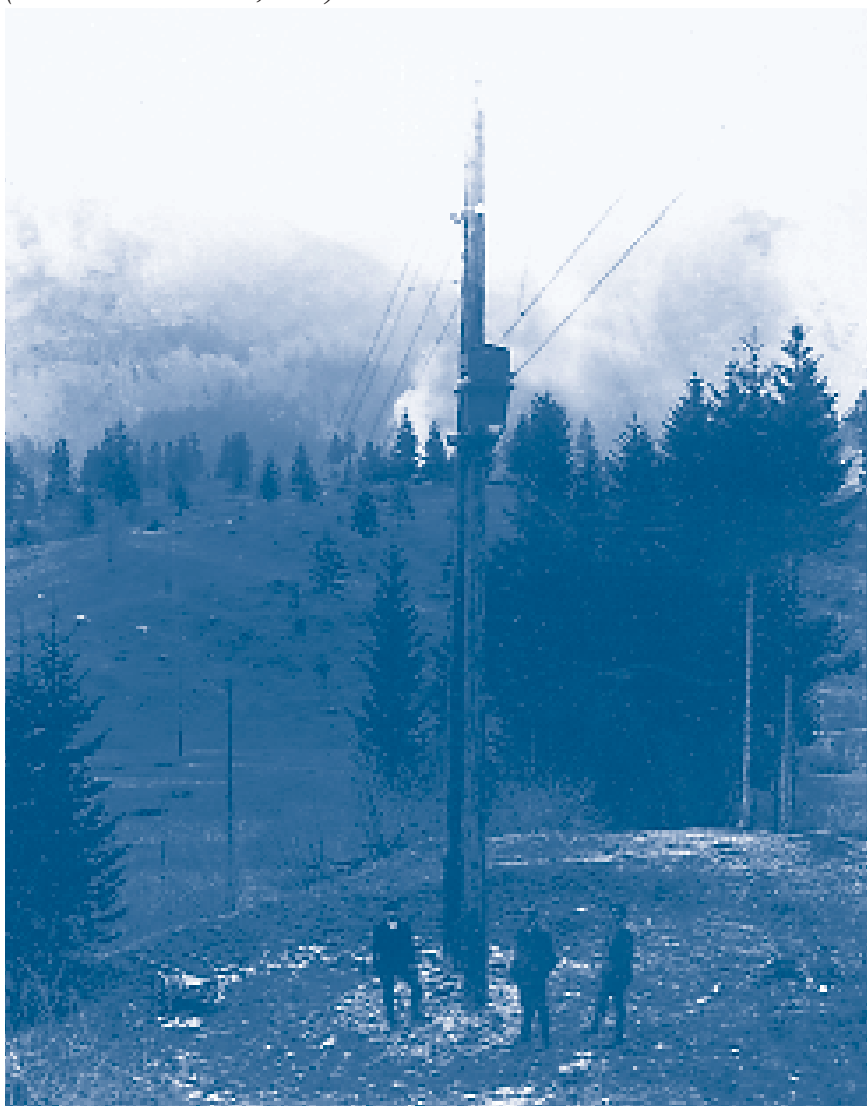
Transformatorska postaja na drogu v bohinjsem kotu (arhiv: družina Solar, Bled)
