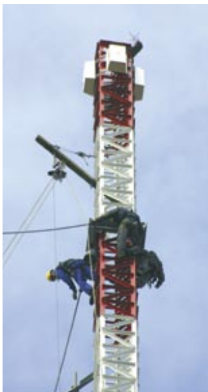
Monterji 100 metrov nad zemljo.
