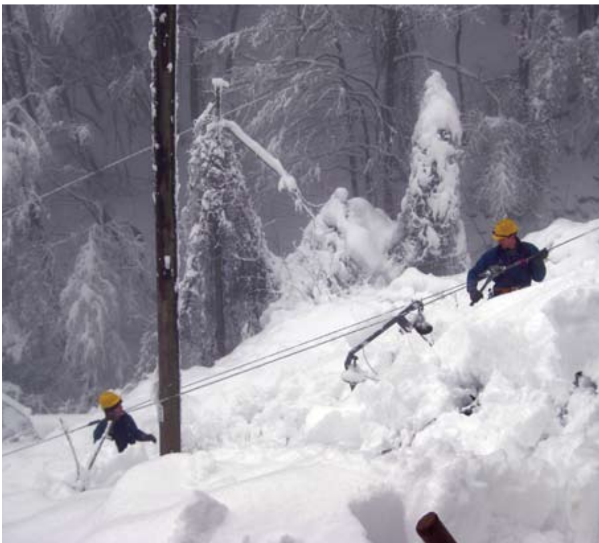
Vzdrževalci Elektra Celje odpravljajo poškodbe omrežja.
