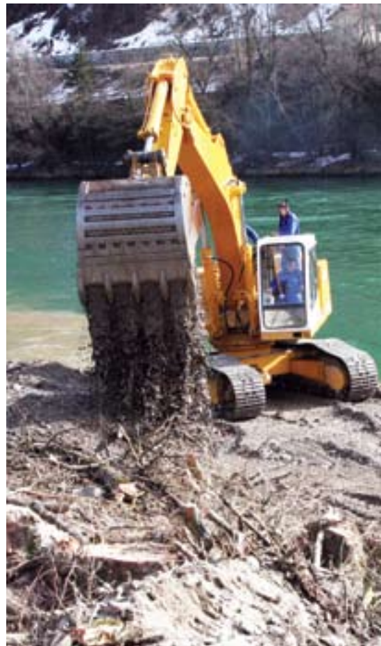
Poglobljanje struge Drave v bližini HE Dravogradu
