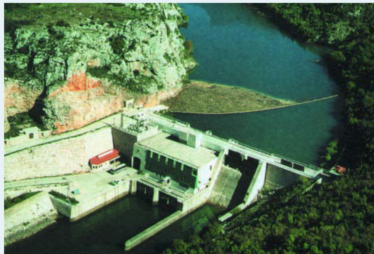
HE Dale na reki Cetinji je ena izmed zadnjih treh hidroelektrarn, ki so jih Hrvati zgradili še pred vojno.
