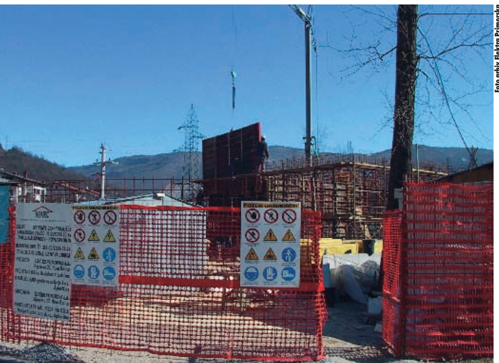
Gradnja RTP Plave-komandna stavba z 20 kV stikališčem.
