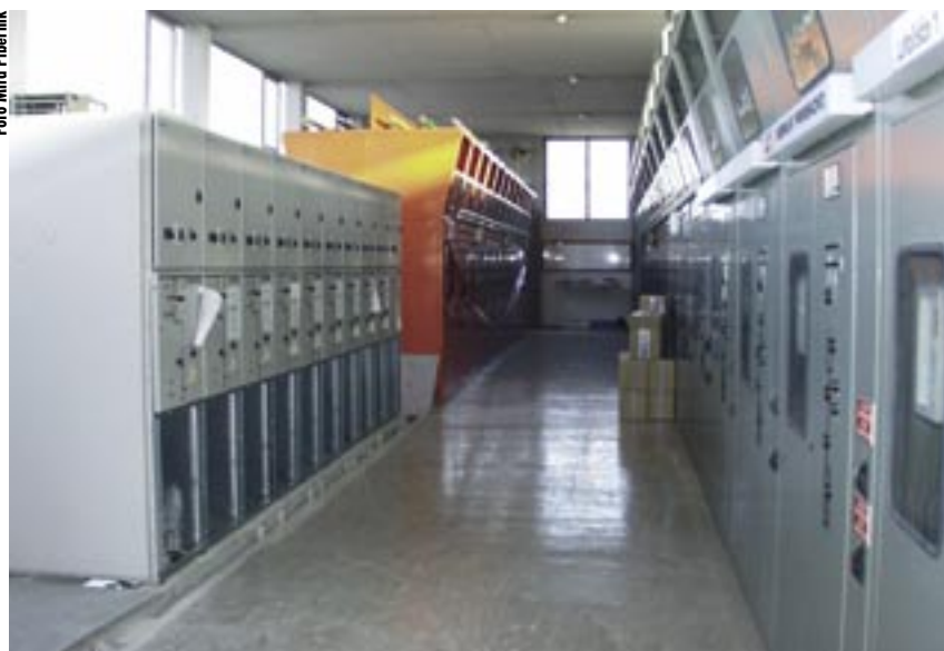
VRTP Primskovo so bile zamenjane 10 in 20 kV stikalne celice.
