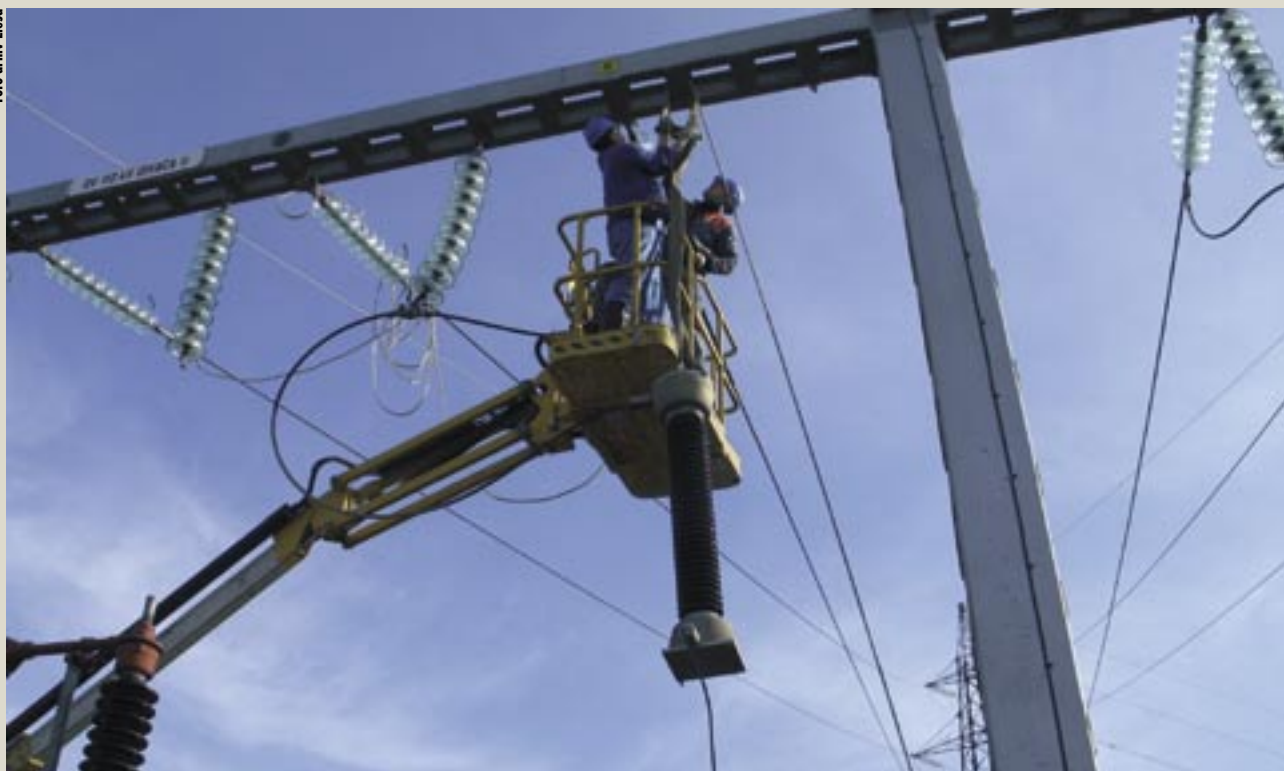
Izvajalci so 23. marca uspešno končali prvo fazo preklonov obstoječih polj na novo stikališče GIS.
