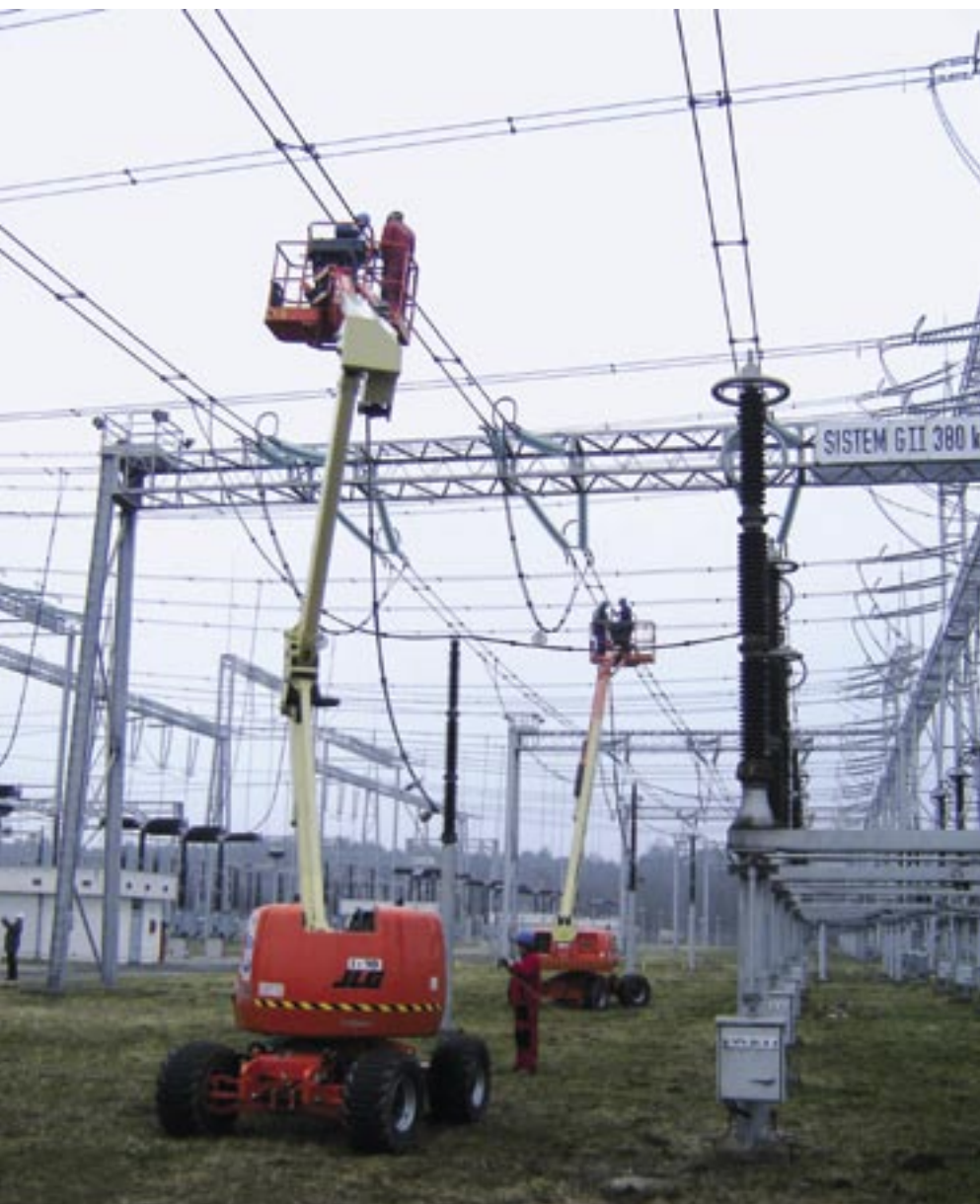
Demontaža primarnih tokovnih povezav za ločilnike v 400 kV daljnovodnem polju Kainachtal 474 v TP Maribor.
