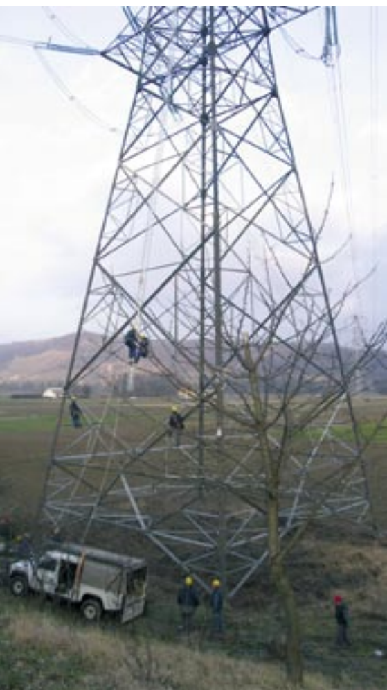
Montaža vzpenjalnih sistemov.
