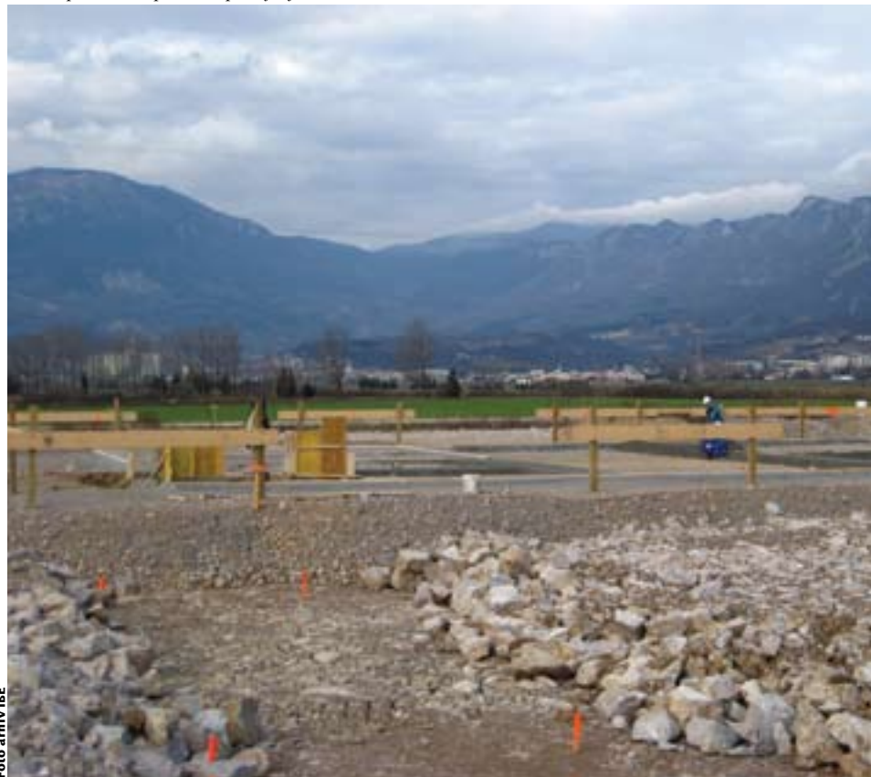
Dela na plinski kompresorski postaji Ajdovščina.
