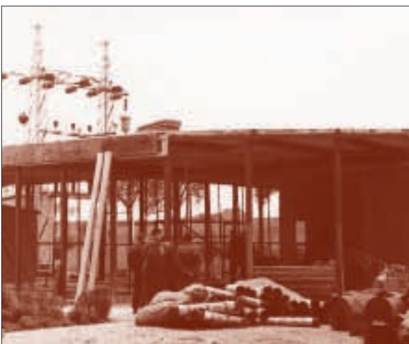
RTP 35/10 kV Labore v izgradnji leta 1959.
