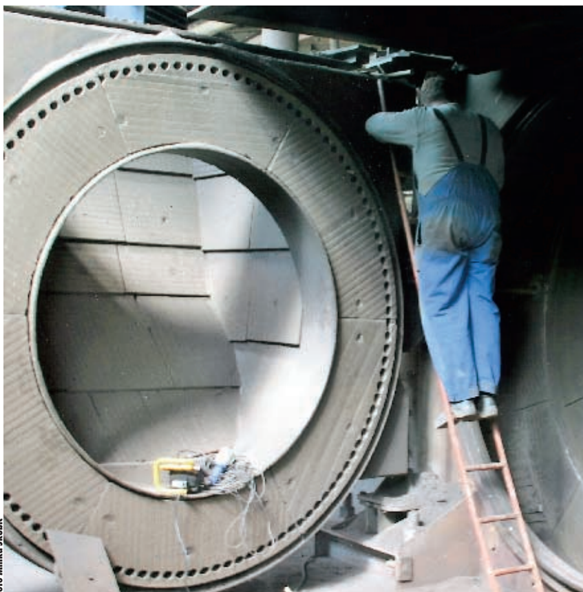
Med vaskoletnimi remontnimi deli je tudi obnova mlinov kotla.
