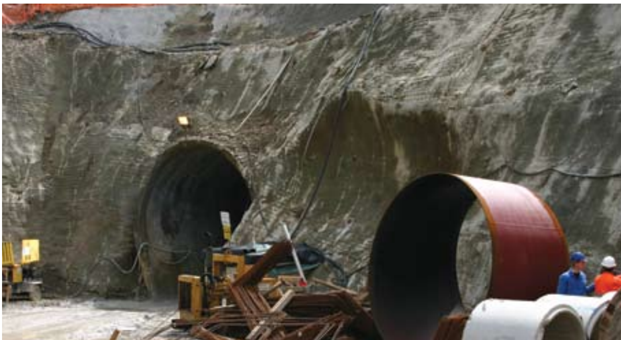
Zaključna dela pri 700 metrov dolgem dovodnem tunelu.
