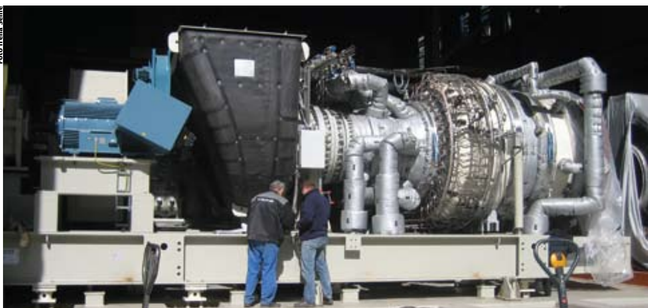
Montaža druge plinske turbine PT52 v TEŠ.
