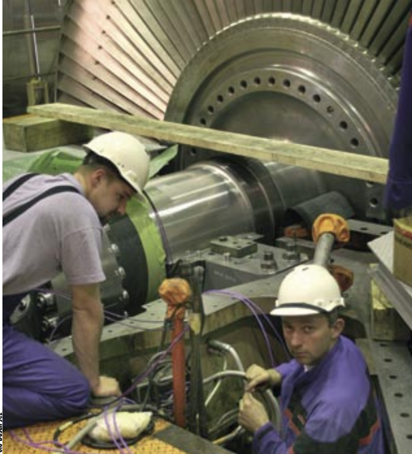
Dela na rotorju nizkotlačne turbine.
