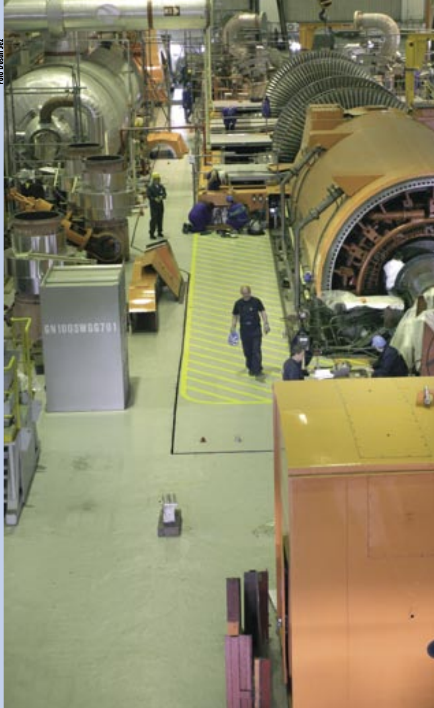
Zamenjava nizkotlačnih turbin, glavna letošnja posodobitev NEK.
