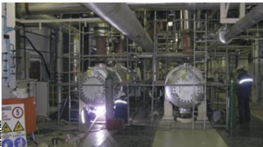
Varilska dela pri zamenjavi visokotlačnih grelnikov napajalne in kondenzatne vode.
