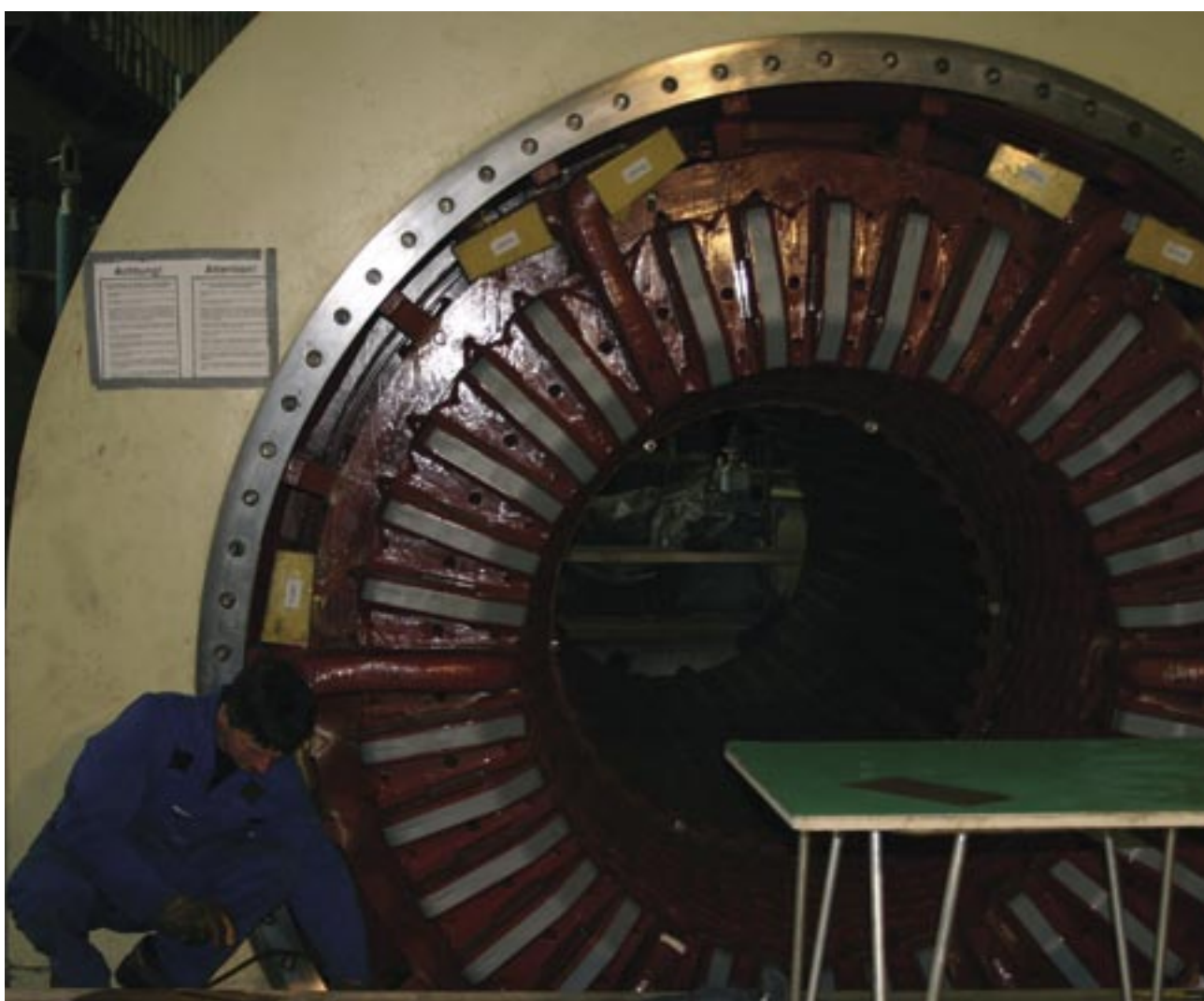
Dolžino tokratnega remonta narekujejo dela na turbini.
