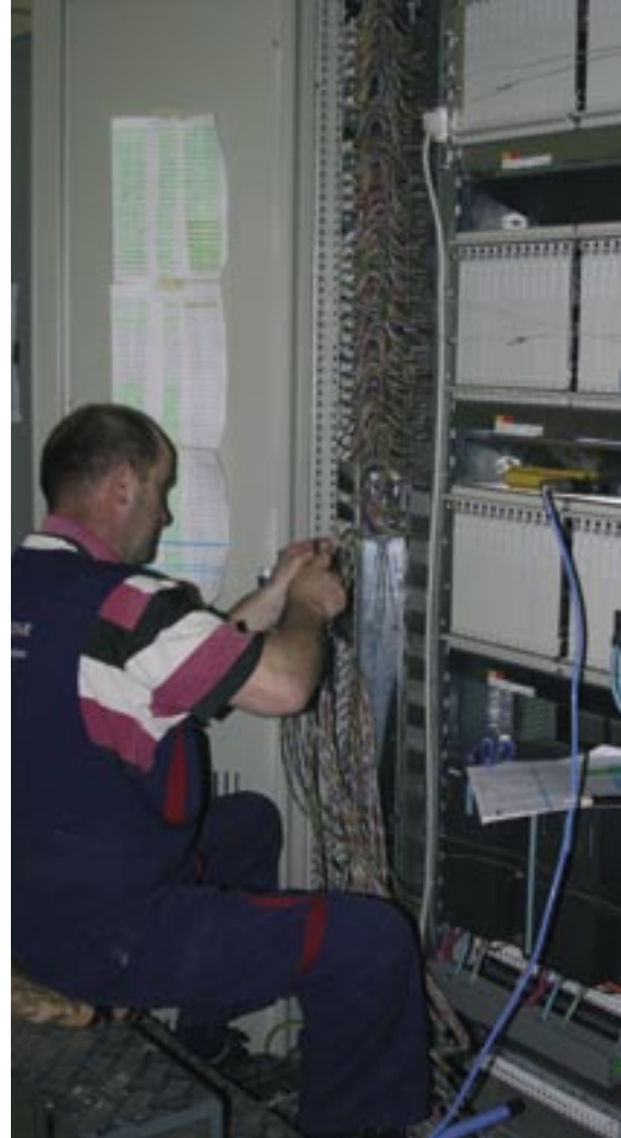
Spajanje številnih vodov v relejno omaro.
