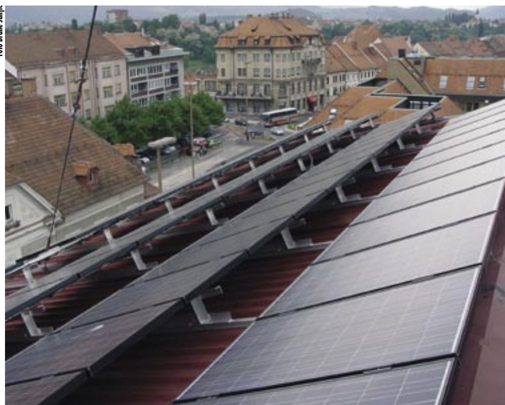
Novi videz strehe poslovne stavbe Elektro Maribor.
