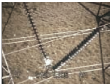
Okvara, locirana na členu v izolatorski verigi, na daljnovodnem stebru in Okvara na glavi odklopnika.
