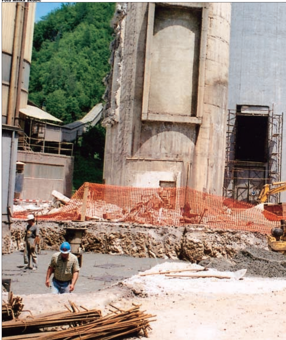
Na dvorišču TET je te dni pravo gradbišče.
