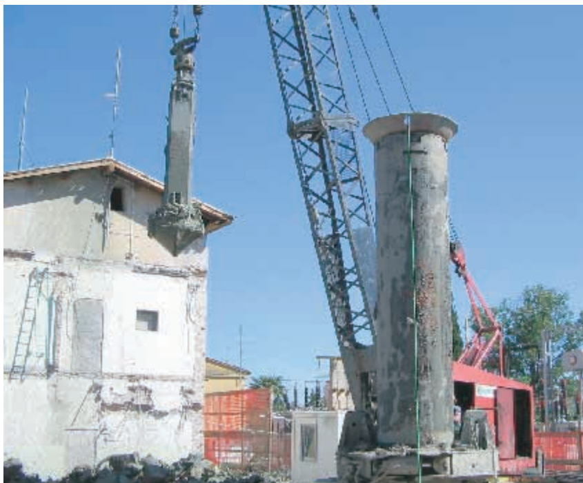
Pred začetkom temeljenja so morali položiti 36 pilotov s premerom sto centimetrov v globino 16 metrov.
