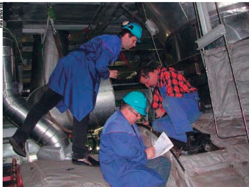
Pregled zgorevalne komore.
