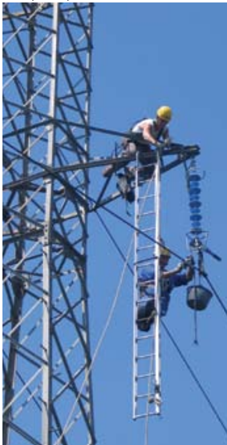
Delavci nameščajo nove kompozitne izolatorje na daljnovodu.
