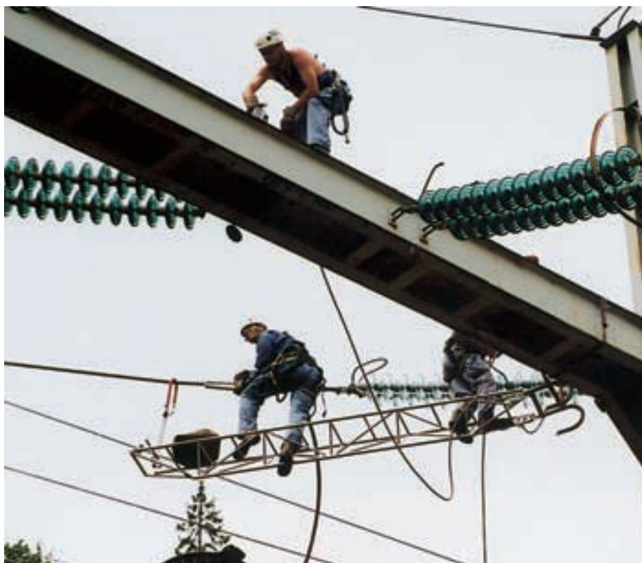
Vzdrževalna dela v 220 kV stikališču.
