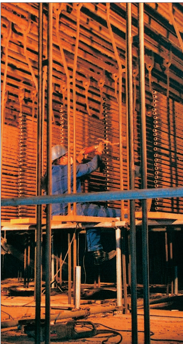
Zamenjava cevi v kotlu.
