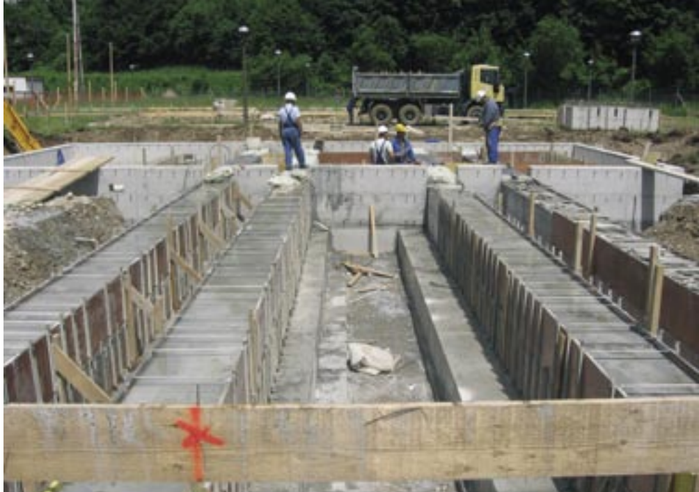
Priprava temeljev za nov transformator.
