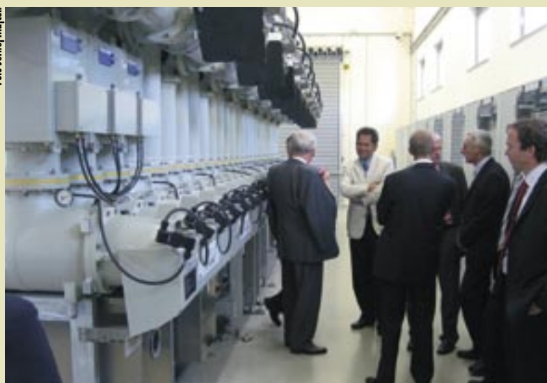
RTP Koper je prvo Elesovo oklopljeno stikališče.
