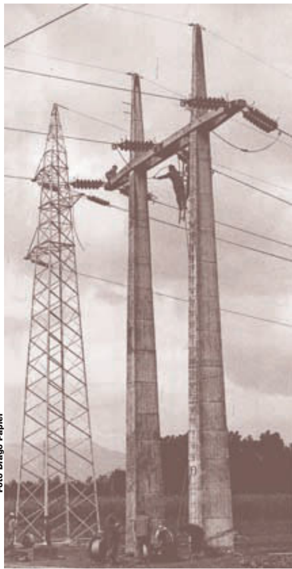
35-kilovoltni betonski daljnovod RTP Kleče-Kranj-Žirovnica v obliki črke H je bil zaščitni znak gradnje petdesetih let.
