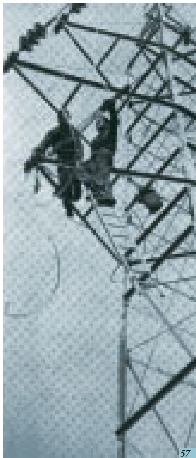
Gradnja daljnovoda 2x35 kV Kleče-Logatec.
