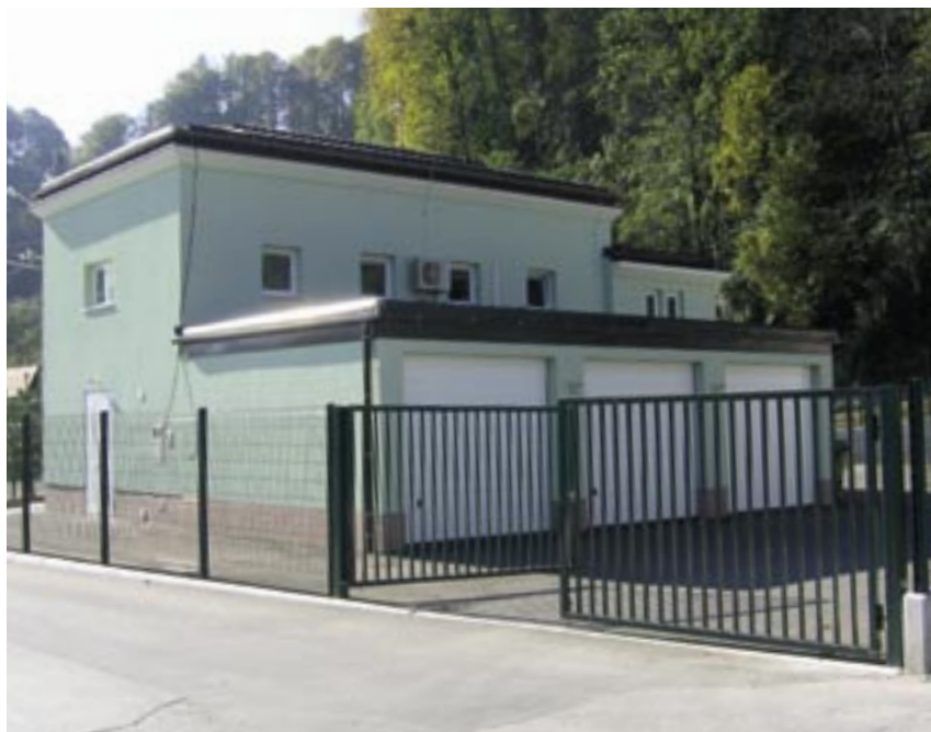
RP 20 kV Laško mesto po končani rekonstrukciji.
