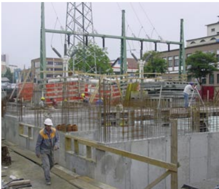
Gradnja stikališča 10(20)kV.
