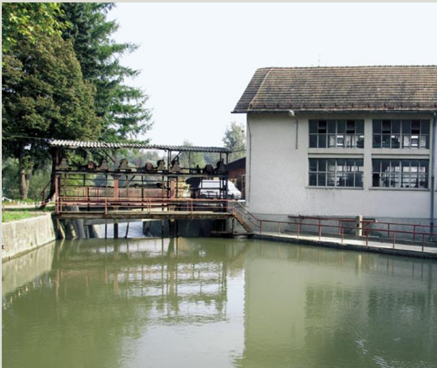
Edino hidroelektrarno na Muri MHE Ceršak bodo temeljito prenovili.
