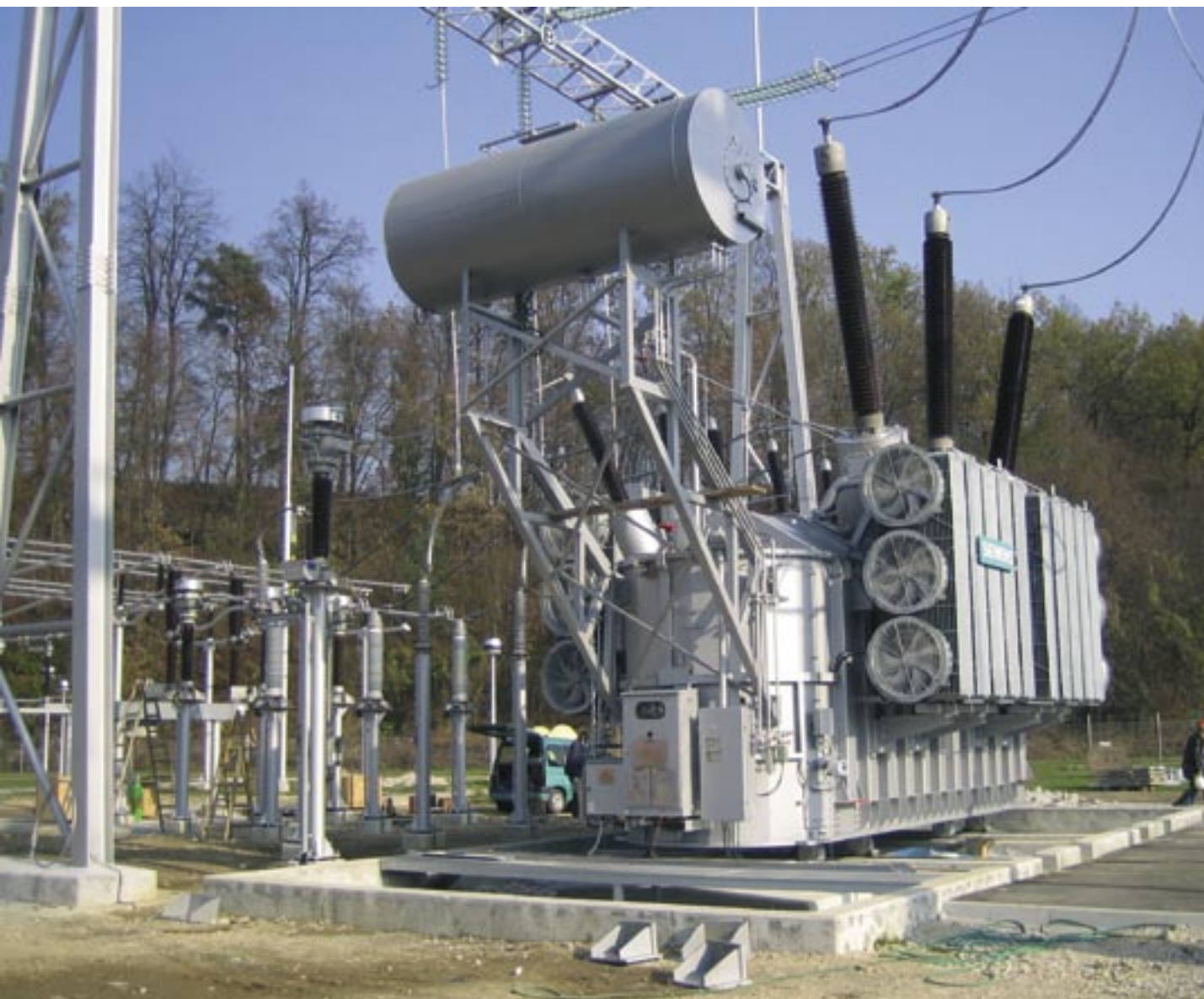
Nov transformator 300 MVA z ONAF hlajenjem v Okroglem.
