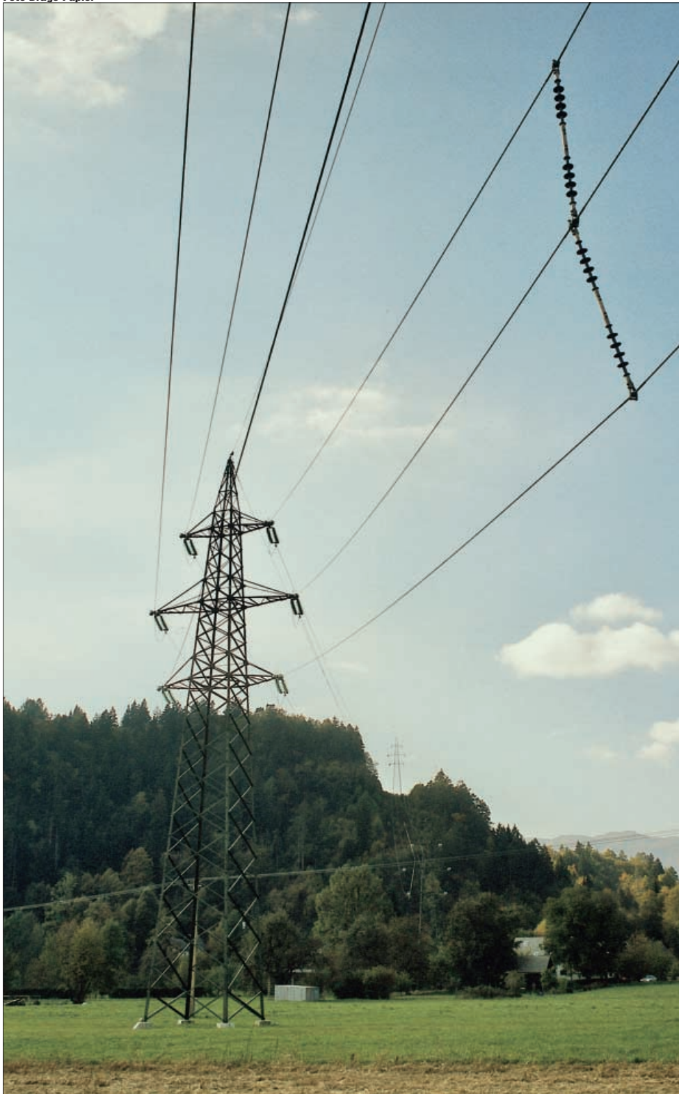
35 kV (zgrajen za 110 kV napetost) daljnovod Bled-Bohinj, zgrajen leta 1988 in opremljen z izoliranimi distančniki leta 1998.
