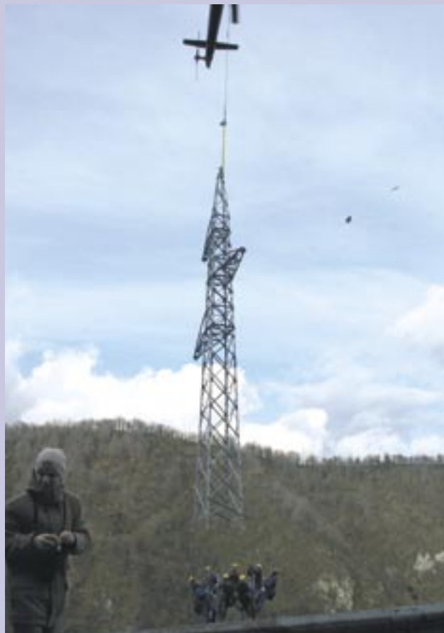
Montaža DV stebra na strmem in nedostopnem terenu nad Trbovljami.
