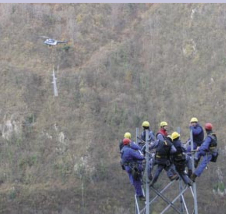
Fantje visoko na stebru pričakujejo helikopter, ki prinaša še zadnji del stebra.
