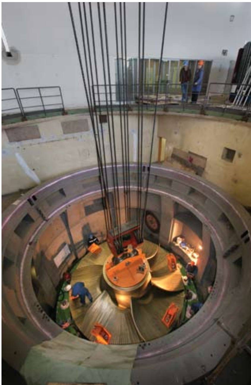
Spust gonilnika v spodnji del turbinskega jaška.
