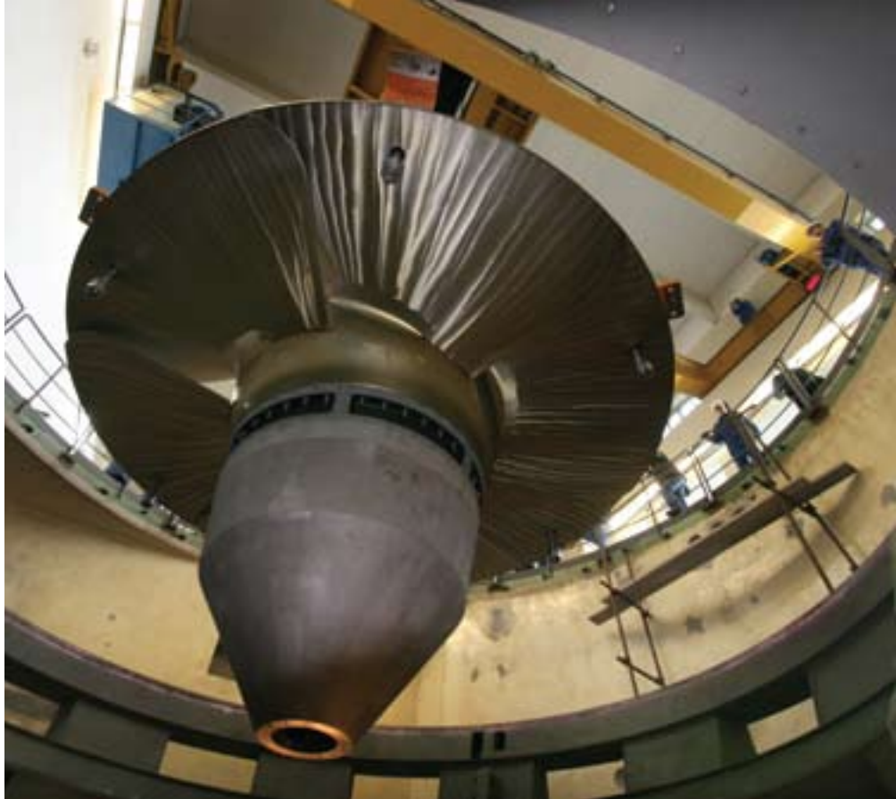
Nameščanje gonilnika za spuščanje v turbinski jašek.
