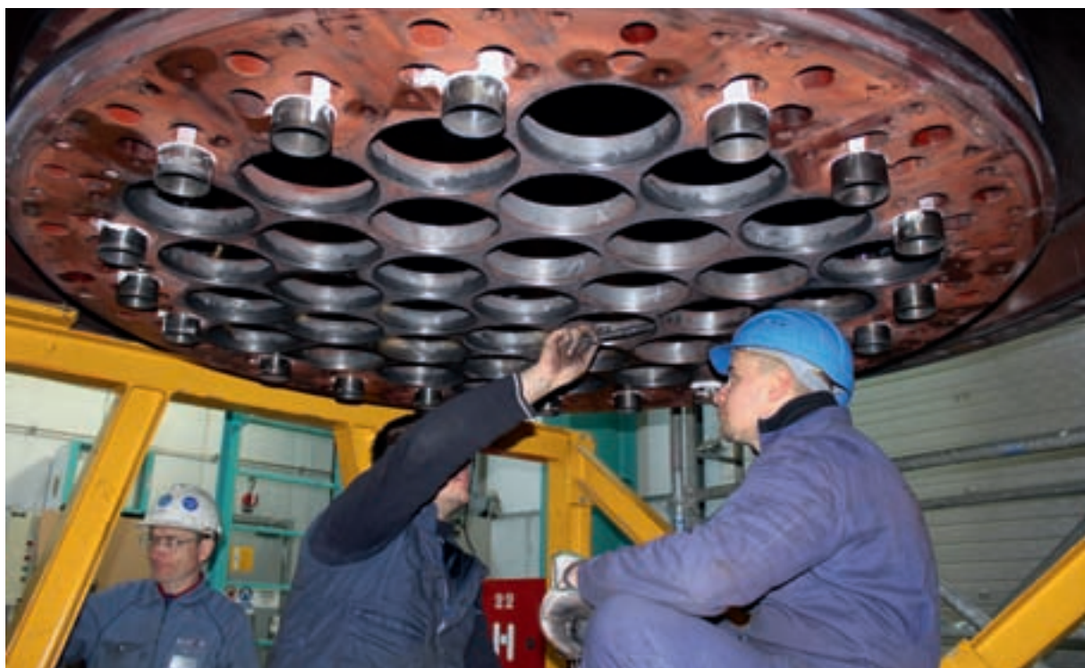
Zgorevalna komora - priprava na montažo gorilnikov.
