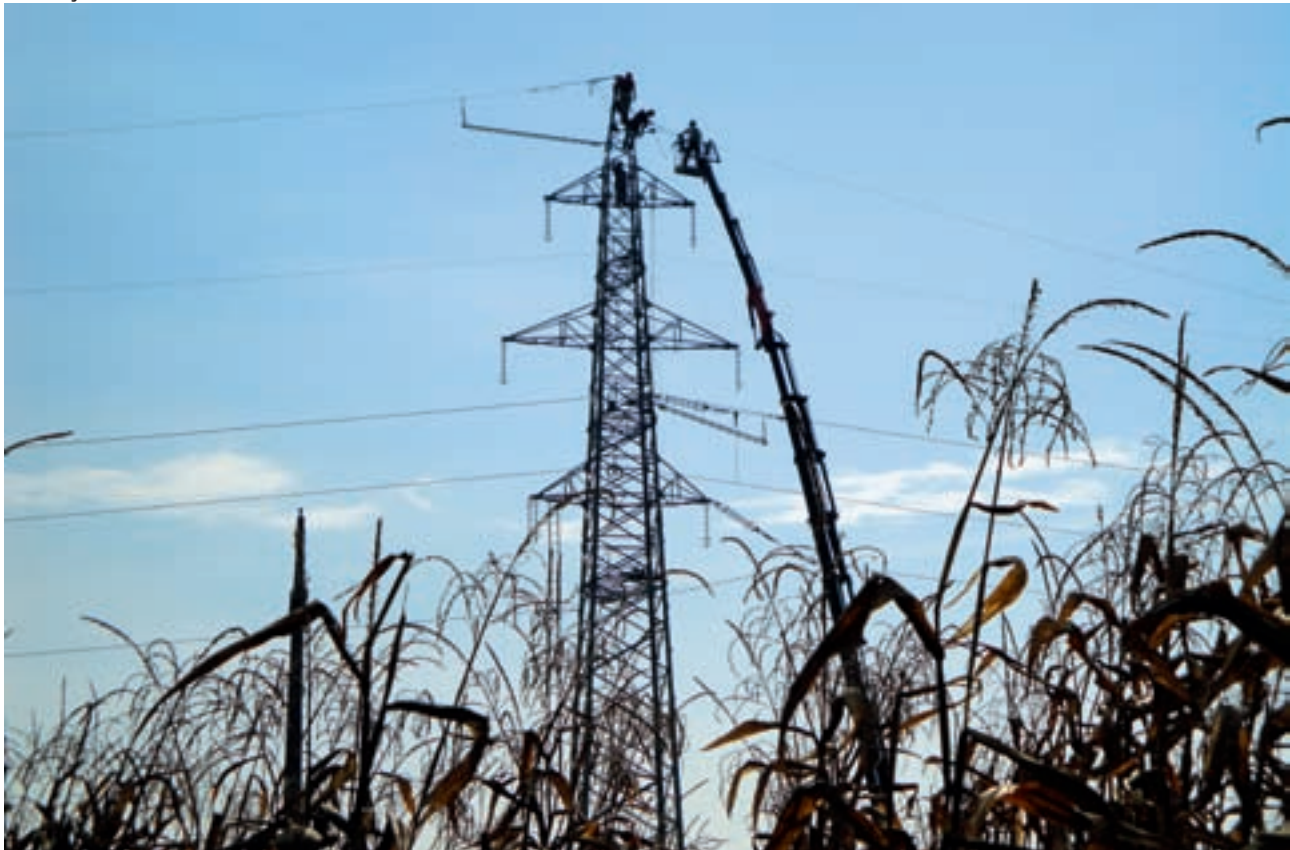
Elektromontažna dela na stebri daljnovoda 2 x 110 kV Ptuj-Breg
