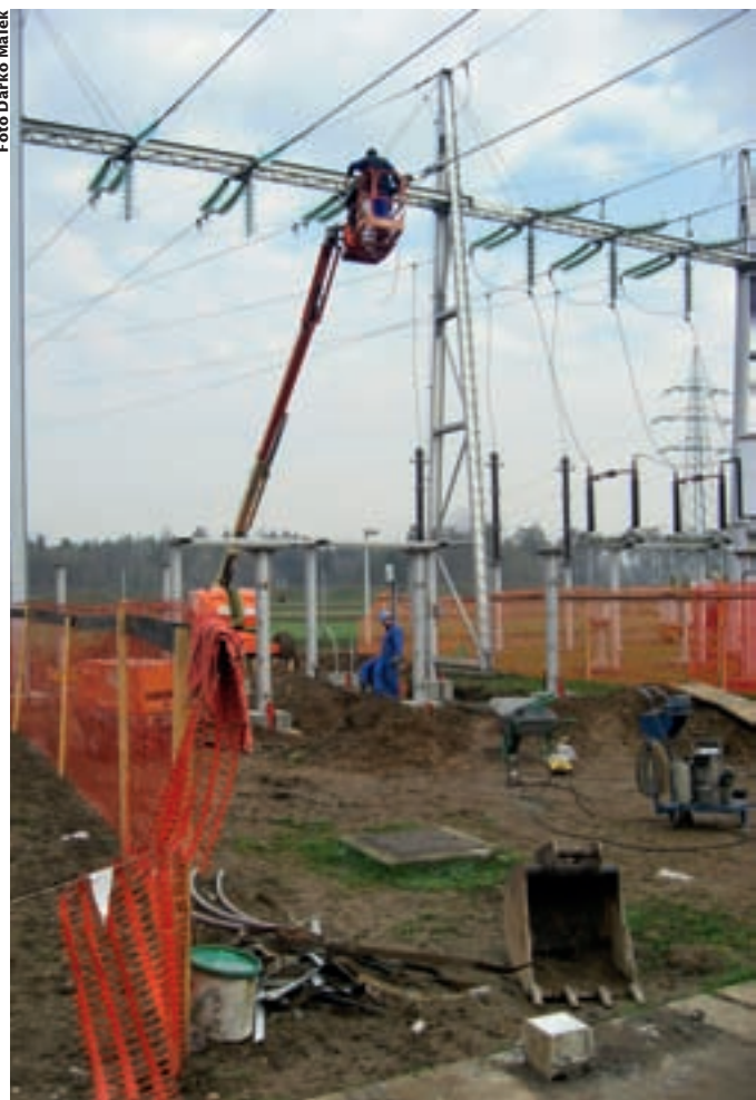
V RTP Maribor je letos potekala tretja faza obnovitvenih del.
