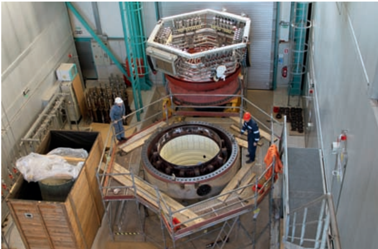
Pogled na zgorevalno komoro, zgornji in spodnji del.
