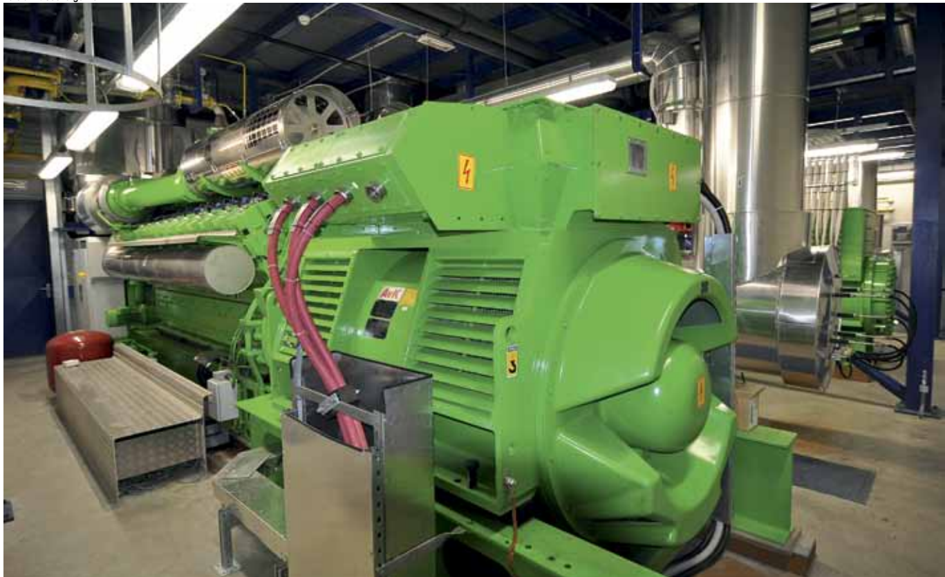
Novi napravi SPTE v kotlovnici na Planini v Kranju.
